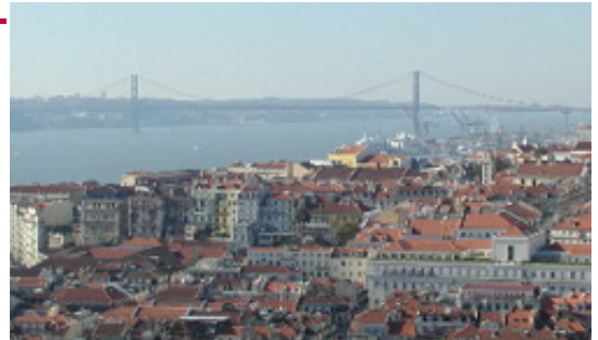
Lisboa. Ponte Vasco da Gama , sobre el riu Tejo
